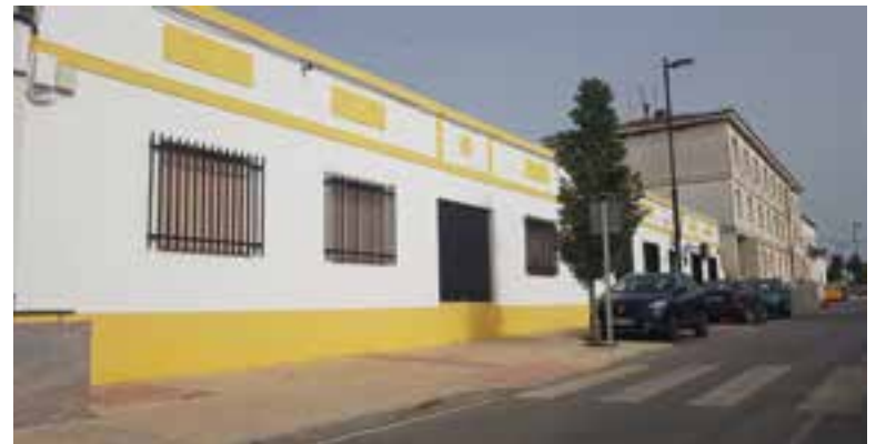
Fachada del local cedido a la Fundación
